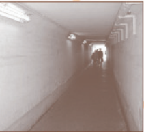
駅の南北をつなぐトンネルで、便利です。道幅が狭く、やや暗いので、注意して歩いてください。
